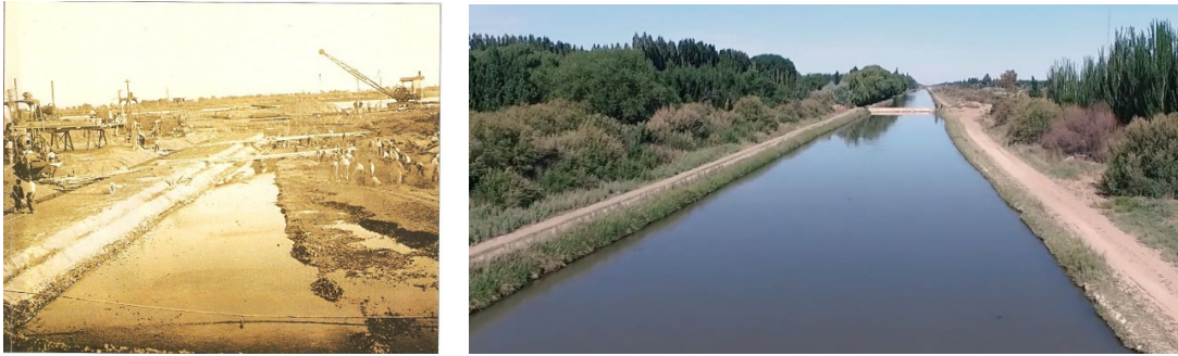
Fig.3 Imágenes de la construcción (Izq.) y del Canal Principal de Riego en zona rural (der)
