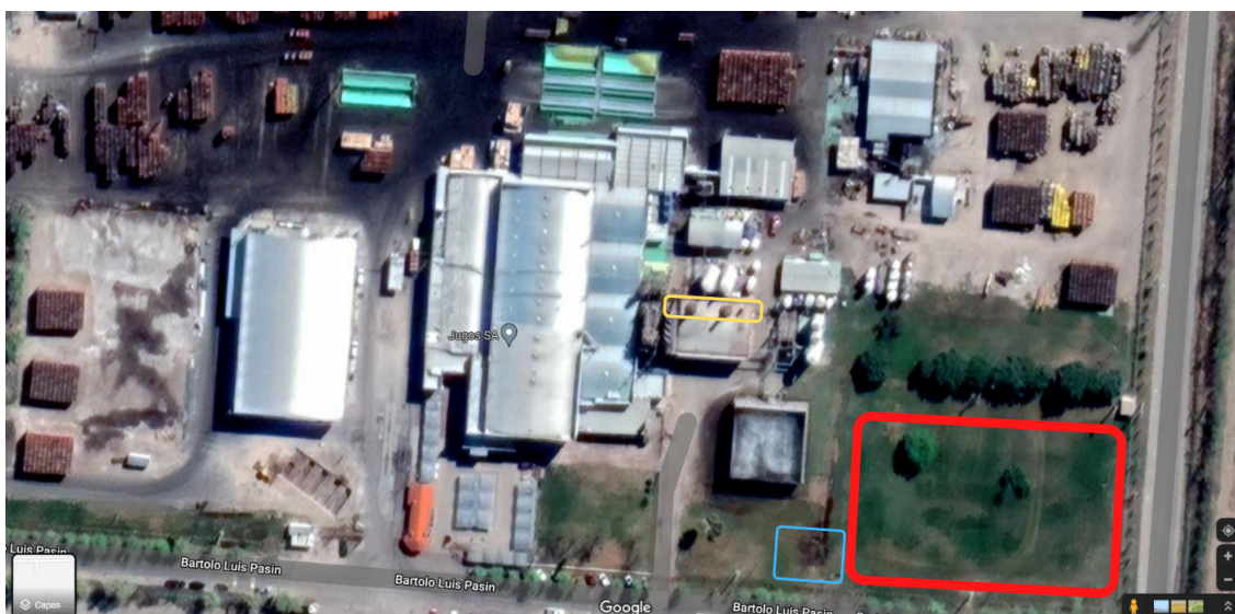
Figura 5.9: Plano de la empresa con las localizaciones de cada lugar En rojo la localización propuesta del fotobiorreactor, en amarillo las chimeneas de las calderas y en azul las bombas de impulsión de las aguas residuales. Fuente: Google Maps.
