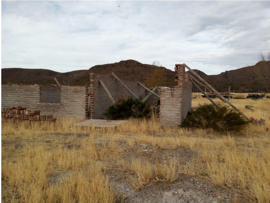
Bungalows en construcción
