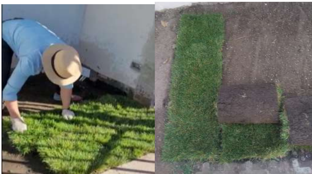
Figura 11. Proceso de instalación de los rollos
