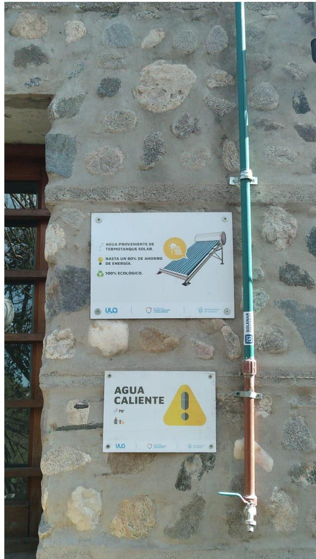
Figura 9: Provisión de agua caliente desde termotanque solar, Universidad Libre de Ambiente, Córdoba (Foto: Joaquín Alegre).
