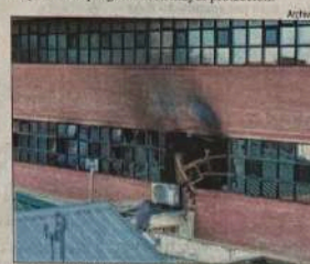
La seguridad del edificio no registró cambios significativos.
