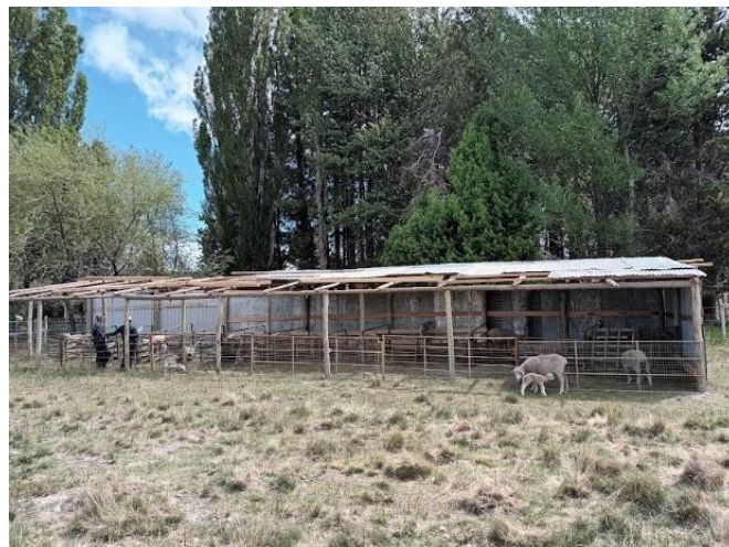
Figura N°24: Vista de exterior del cobertizo. Fuente: Propia (2022).
