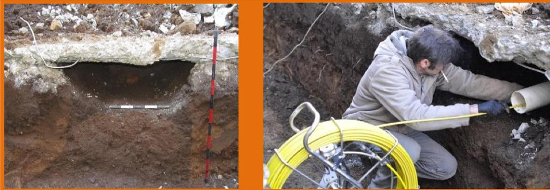
Figura 37. Trabajos de inspección por video del ducto en Mitre 073.
