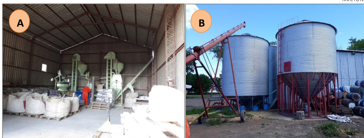
Figura N°17: A- Planta de alimento en su interior; B- Silos en el exterior de la planta. Fuente: Propia.
