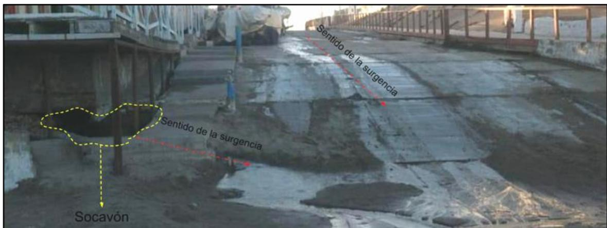
Fig. 3.36. Vista frontal de la Bajada de lanchas de la Bajada 3. Se exhibe surgencia de agua desde la mitad de la bajada de lanchas, además de un brote en la parte final de la misma, en contacto con la playa, provocando un socavón en los cimientos del parador de la Bajada 3.
