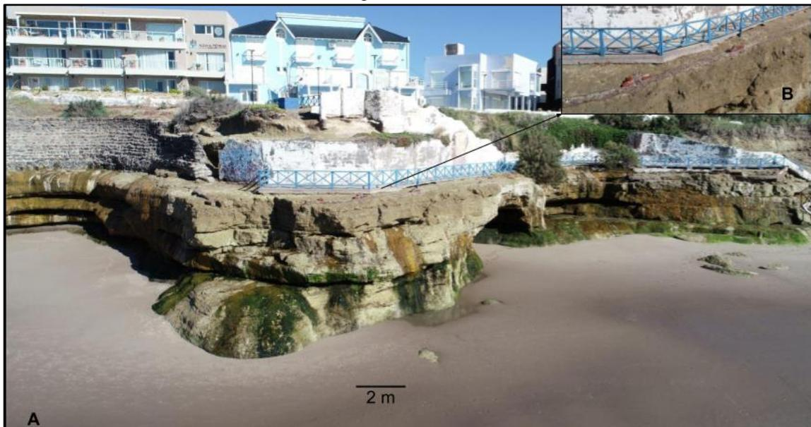
Fig. 3.46. (A) Vista frontal tomada con VANT del promontorio más pronunciado del área de estudio, destacan los muros de contención sobre el acantilado y la surgencia de agua. (B) Vista con zoom, exhibiendo los cimientos de un antiguo muro de contención.
