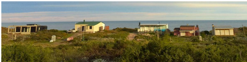
Figura 12: Construcciones cercanas al acantilado. (Autor: Castillo Aluminé)
