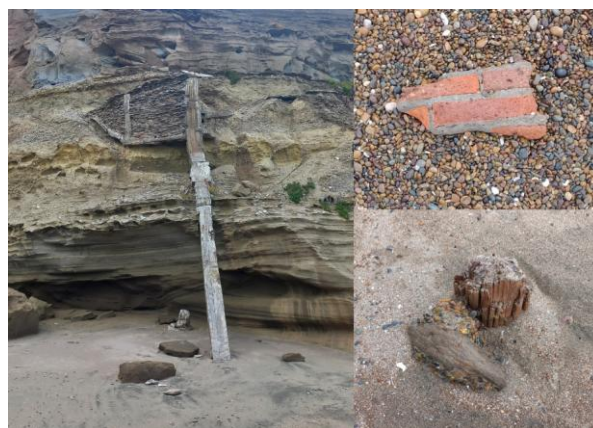
Figura 13: Restos de infraestructura en la playa. (Autor: Castillo Aluminé)
