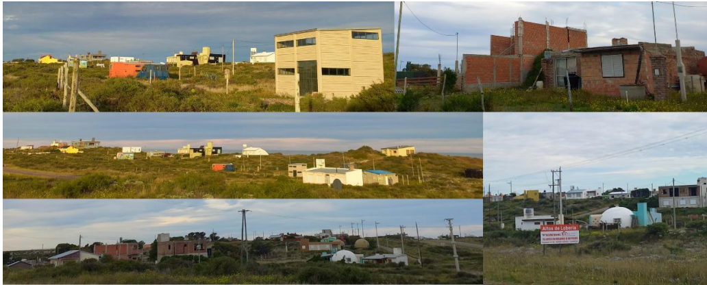
Figura 11: Viviendas en La Lobería. (Autor:Castillo Aluminé)
