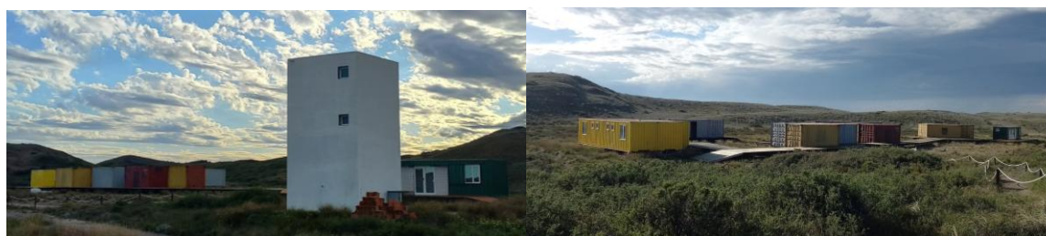
Figura 36: Construcción del nuevo centro de interpretación. (Autor Pereyra Almerna Camila)
