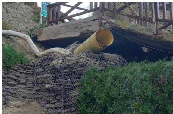
Figura 24: Caño de desagüe pluvial. (Autor: Castillo Aluminé)
