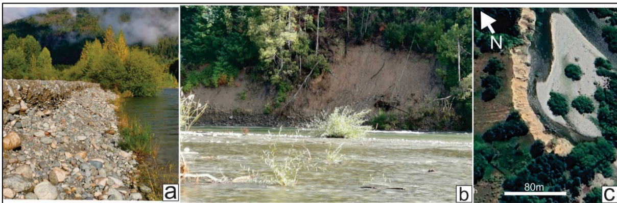
Figura 32: Distintos márgenes del río. En a: Margen derecha del canal, donde se encuentra el terraplén destacando la erosión del mismo. Fotografía tomada en el campo. En b: Margen izquierda erosionada del río inmediatamente aguas arriba del terraplén. Fotografía tomada en el campo. En c: Erosión del margen izquierdo del canal aguas arriba, visto desde una imagen satelital. Foto tomada desde Google Earth.
