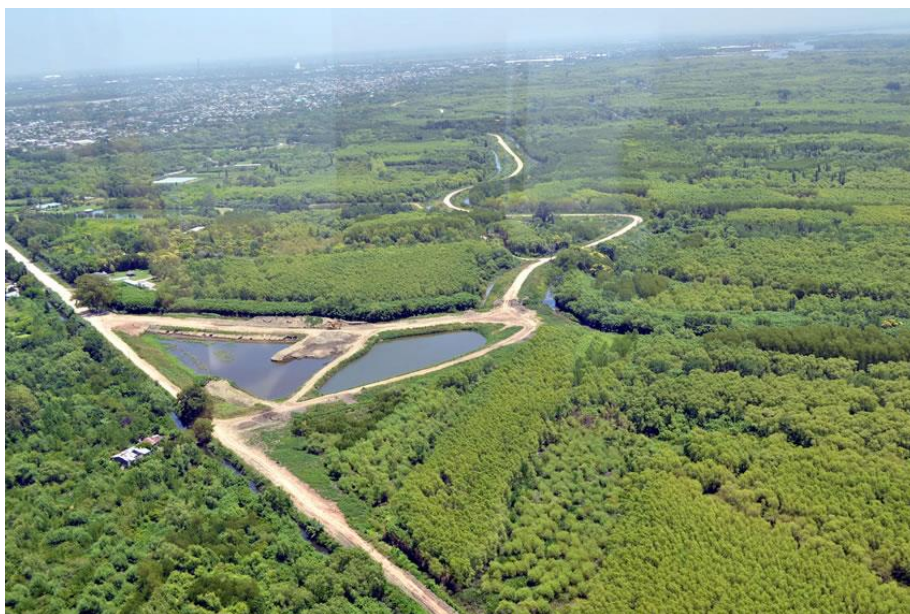
Figura 28. Detalle del terraplén costero. Municipio de Berisso.
