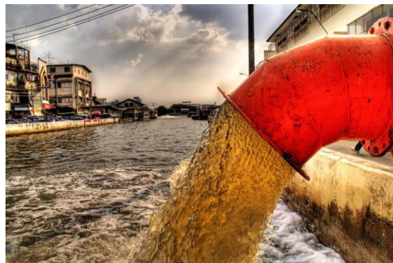
FIGURA 2: NOTA: EJEMPLO DE DESCARGA DE AGUAS RESIDUALES. EXTRAÍDO DE FUNDACIÓN ECOMAR
