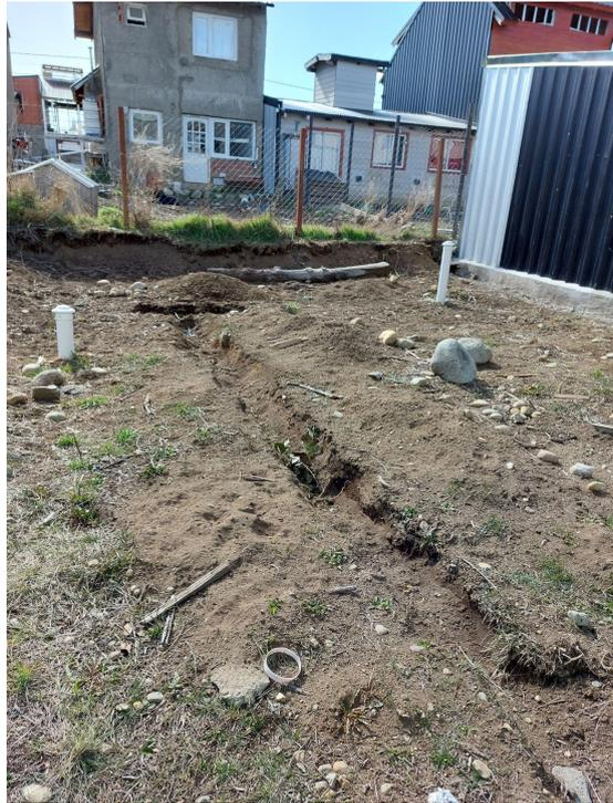
*Imagen 5. Construcción de sistema de tratamiento in situ.*
