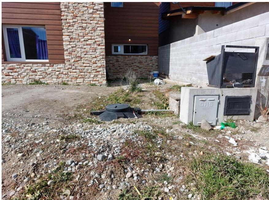
*Imagen 8. Presencia de cámara desengrasadora/de inspección y cámara séptica.*
