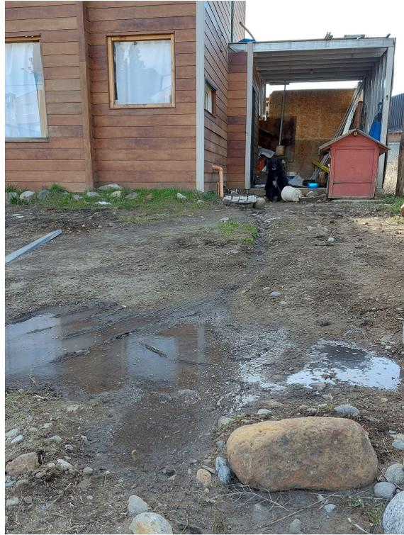
*Imagen 7. Observación de anegamiento por efluentes provenientes de cámara desengrasadora.*
