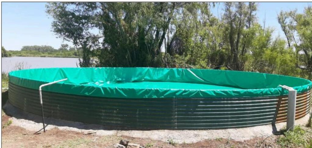
*Figura 8.2: ejemplo de una tanque australiano sobre platea de cemento y funda (Lonera LJ, 2022).*
