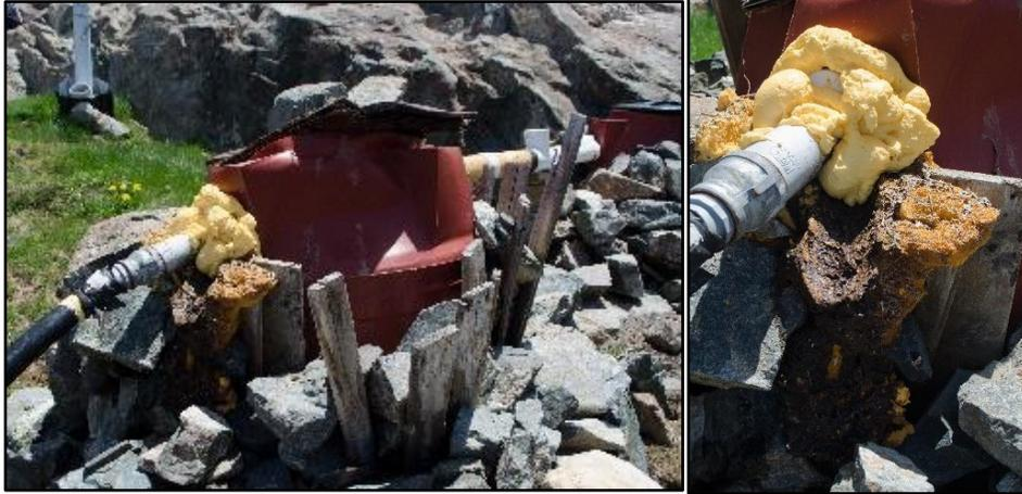
Figura 43. Reparaciones en las uniones a la salida.
