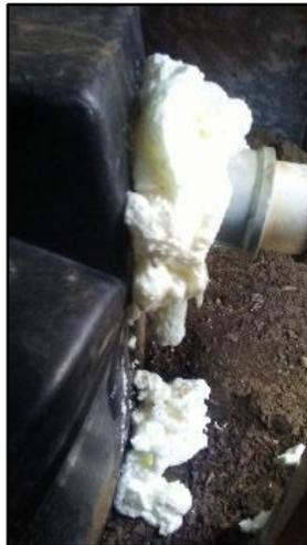
Figura 48. Reparaciones a la salida del biodigestor N°2
