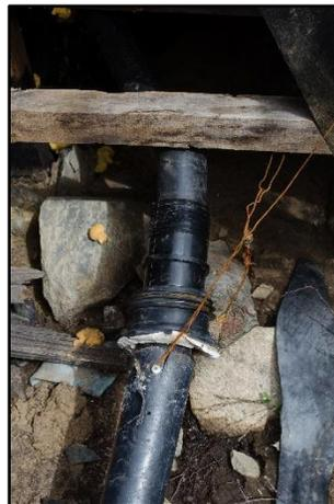
Figura 59. Reparaciones en las uniones a la salida del biodigestor N°2
