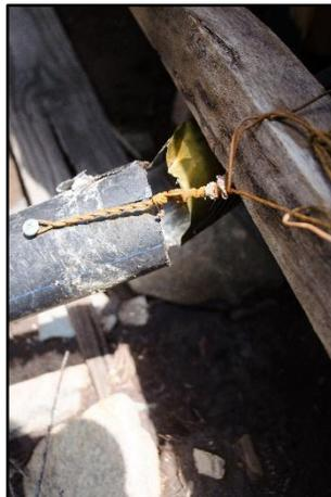
Figura 55. Reparaciones a la salida del biodigestor N°2
