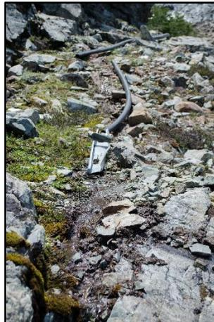
Figura 57. Estado de la cañería en la zona de vuelco N°2
