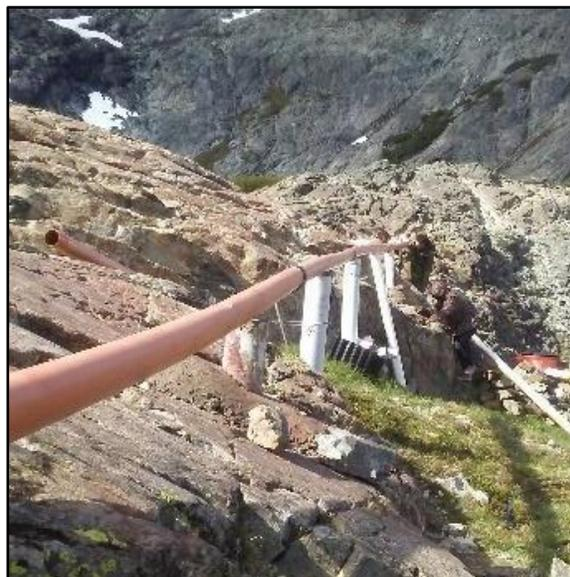
Figura 47. Instalación de la cañería
