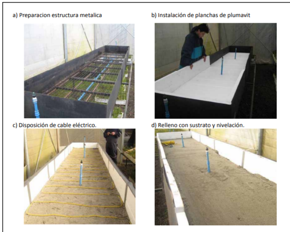
Figura n°24: Proceso de preparación de la cama caliente
