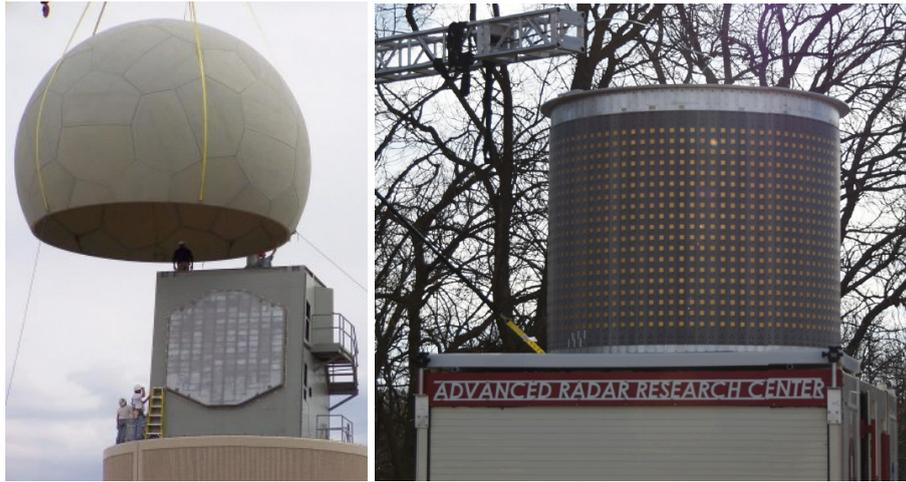
Figura 1.1. Arreglos de sensores utilizados en radares meteorológicos: (a) arreglo plano de cuatro caras [9]; (b) arreglo cilíndrico [10].
