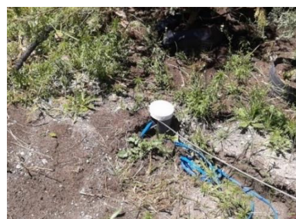
Figura 91. Detalle pozo con toma de agua
