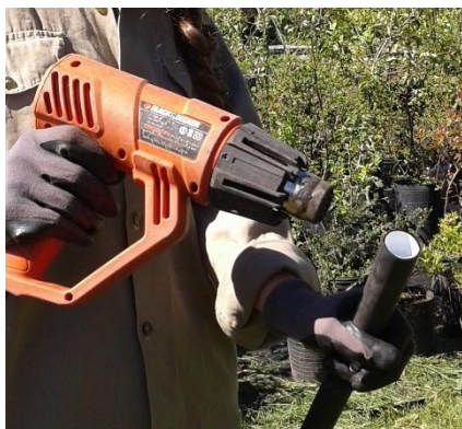
Figura 98. Proceso de ablandado de caños para realizar el empalme
