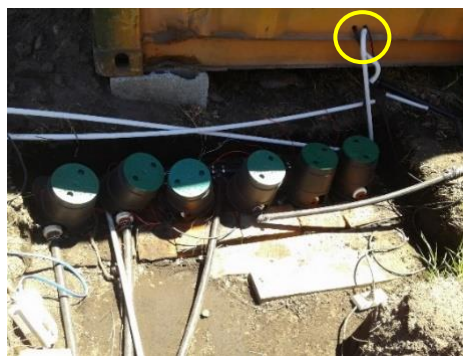
Figura 93. Cabezal de riego
