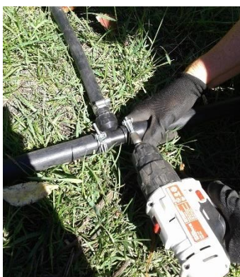
Figura 99. Proceso de ajuste de abrazaderas
