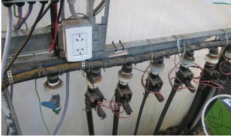
Figura 7. Cabezal de riego y electro-válvulas.
