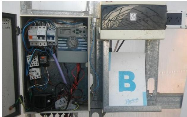
Figura 8. Tablero eléctrico donde se ubican el disyuntor diferencial, las térmicas y el programador de riego.
