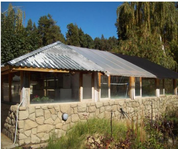
Figura 24. Cambio de cobertura del invernadero. Reemplazo de clapas de fibra de vidrio por nylon.
