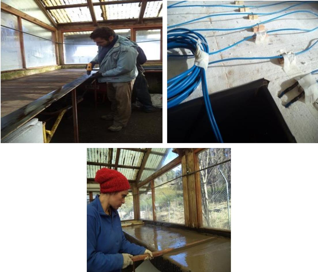
Figura 26. Construcción de sistema de calefacción basal sobre las nmesadas perimetrales.
