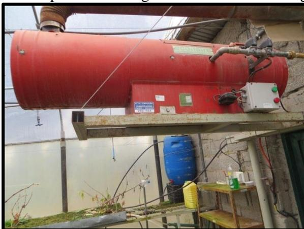
Figura 5. Caldera a gas con sensor de temperatura
