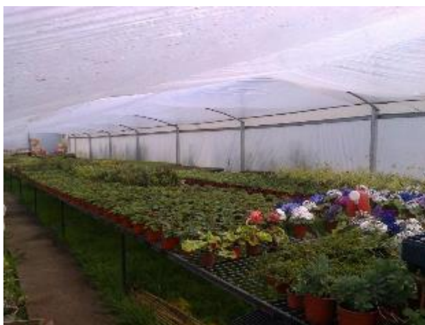
Figura 8. Pared de polietileno que separa la nave fría
