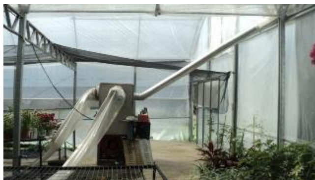
Figura 13. Vista lateral, tubo para expulsión de gases
