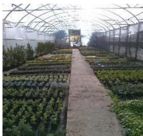
Figura 11. Nave fría, sin mesadas.
