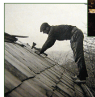
Construcción del refugio en 1933.
