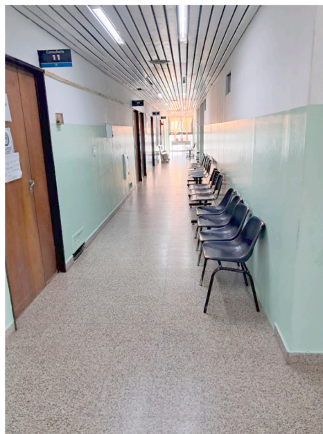
Consultorios 1er piso. El hospital se fue ampliando a fin de crear nuevos consultorios, esto produjo una gran reducción del pasillo principal, dejando solo unas pequeñas ventanas en los extremos del mismo.
