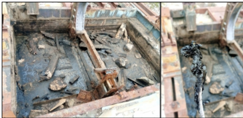
Figura 19. Estructuras abandonadas de la ex Mina Gonzalito (Fuente: Elaboración propia).
