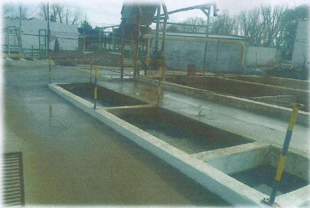
Figura 15. Piletas de decantación de aguas residuales.
