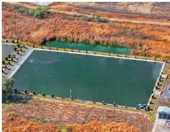
**Figura 2.10. Laguna de Estabilización Anaeróbica. [Armando Marín Ocampo, Manuel Osés Pérez, 2013]**
