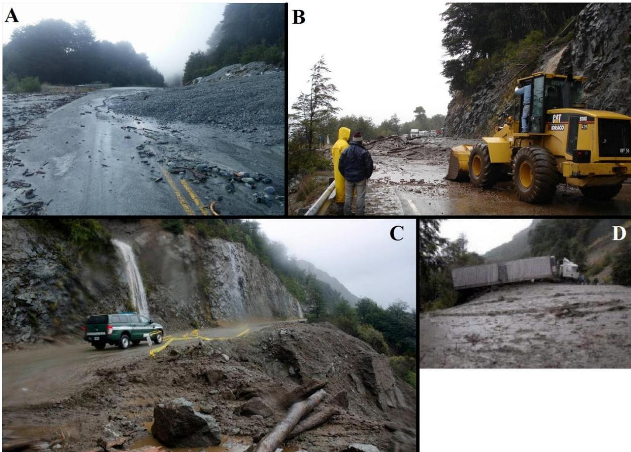
Figura 9.11. Flujos de detritos originados a partir de deslizamientos de suelos y detritos en la parte alta de la montaña, en diferentes sectores de la ladera oriental del cerro Padre Laguna. A. Imagen tomada de Noticias del Bolsón B. Imagen tomada de Bari Noticias (15/07/08). C. Imagen tomada del diario Río Negro (18/05/15). D. Imagen tomada de anbariloche del (22/05/09).
