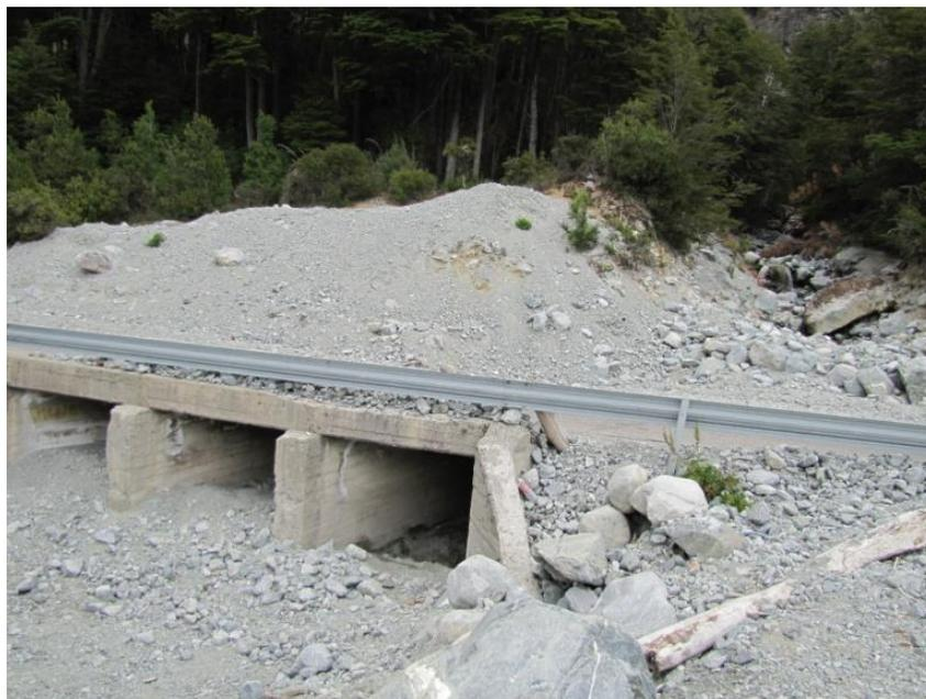
Figura 3.8. Depósitos de remoción en masa sobre la R.N. 40 en la zona del lago Guillermo.
