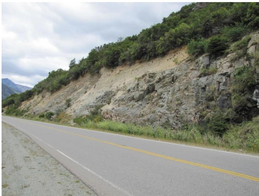
Figura 3.7. Depósitos de till sobre afloramientos del basamento en un corte de camino en la R.N. 40.
