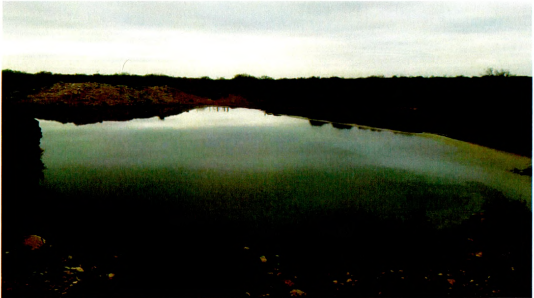
Figura 7: Laguna de decantación de efluentes
