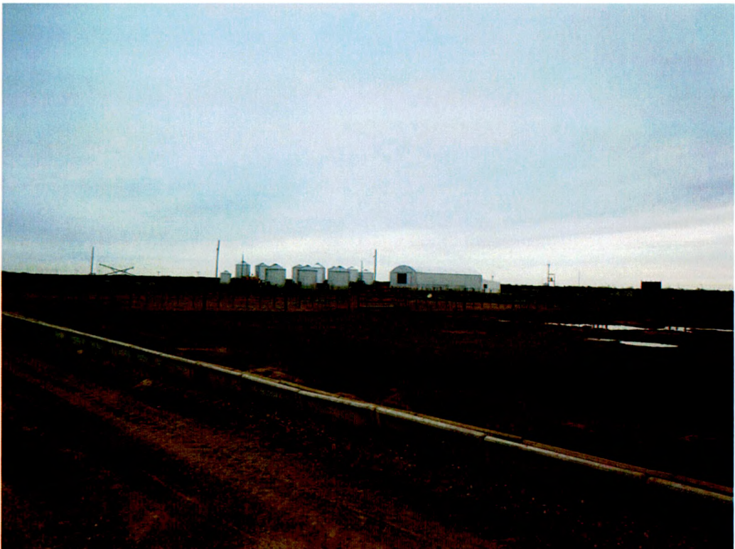
Figura 6: Infraestructura: galpón y silos
