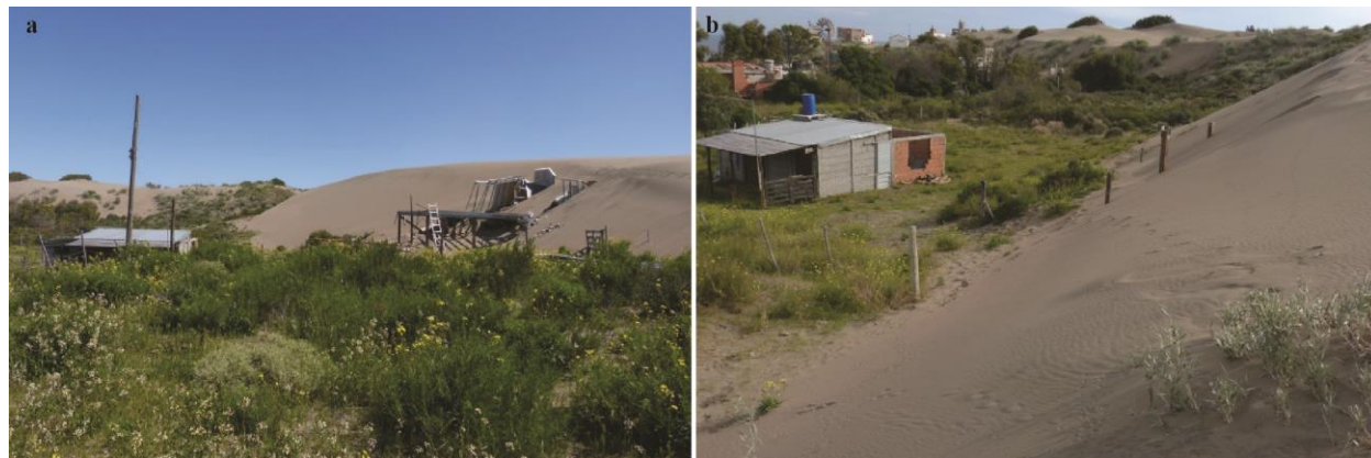
Figura. 7.24. Fotografías tomadas en octubre de 2016 (a) y mayo de 2017 (b) apuntando hacia el O – NO y SO respectivamente. Aquí se aprecia como la estructura ya arrasada por las dunas en unos meses es cubierta totalmente. También se ve como esta duna avanza hacia la siguiente casa en dirección S – SE.
