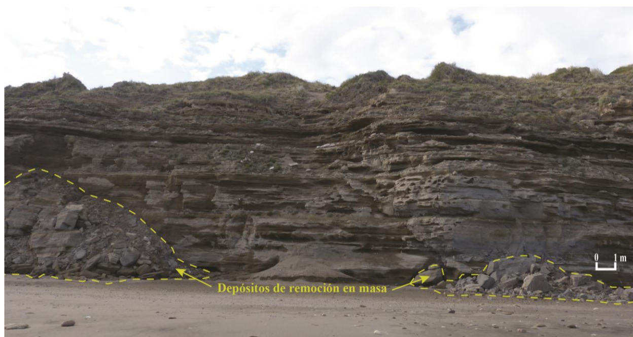
Figura 7.5. Erosión causada por remoción en masa en el sector A.
