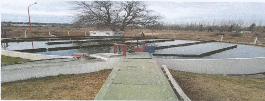
3. Luego pasa por otro canal en el cual el agua se manobra por medio de válvulas o compuertas para ser dirigida a tres filtros diferentes.
