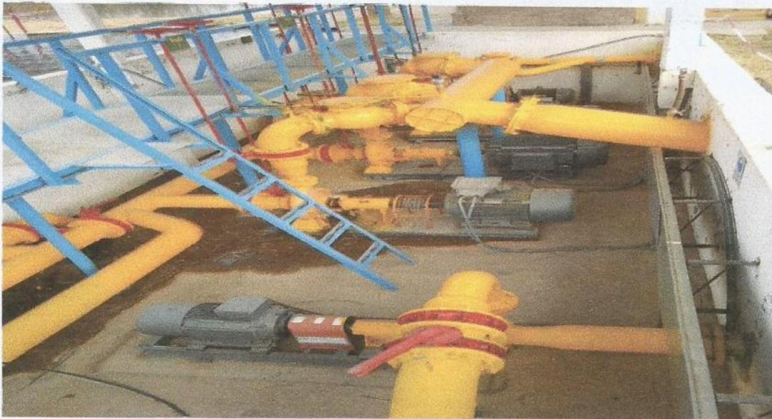
5. Llega al conducto principal en el cual a los 5mt de circulación se le inyecta una dosis de hipoclorito de sodio.
