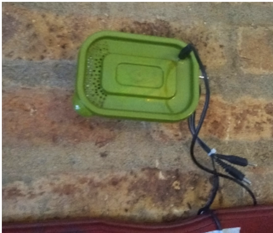
Fig 18. Prototipo instalado y funcionando, luego de la modificación en la carcasa.
