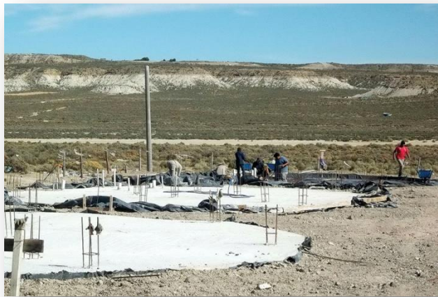
Imagen 24: fotografía de la edificación de las ruka 97
