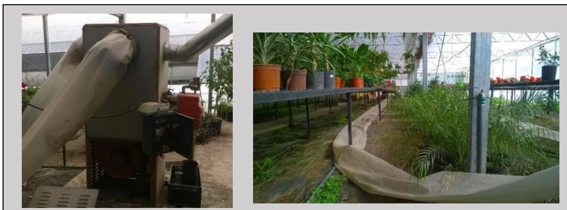
Figura 10. Mangas de calefacción, debajo de las mesadas, se inflan con el aire caliente (plantas de interior)
