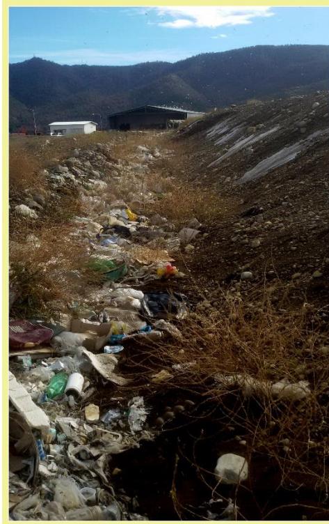
Figura 7: Canaleta de evacuación de aguas superficiales obstruida con residuos diversos. Fuente: propia.
