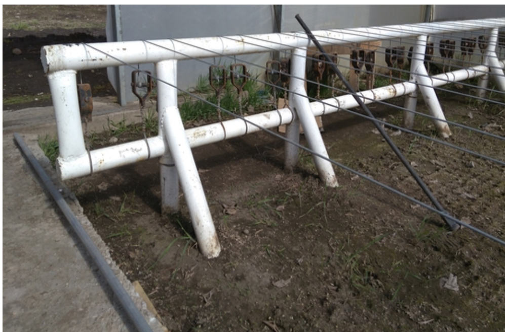
Figura 6: Detalle caballetes, cables y tensores de las camas.
