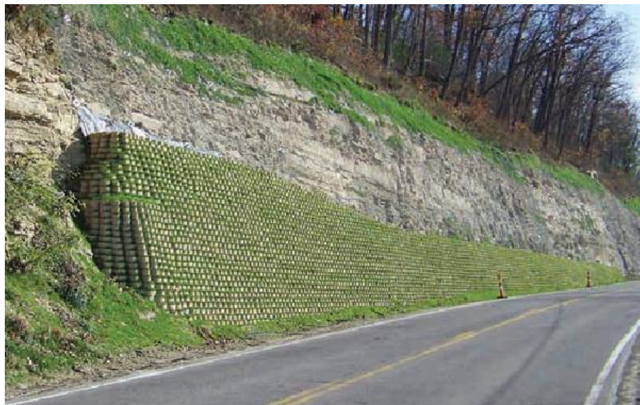
Figura 34: Sistemas GeoWeb son versátiles, económicos, se adaptan a los diferentes tipos de suelo y crean una estructura viva con vegetación cumpliendo los requisitos del diseño estructural. Fuente: https://www.prestogeo.com .
