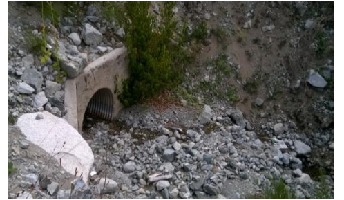
Alcantarillas de D2 (desde la costa).
