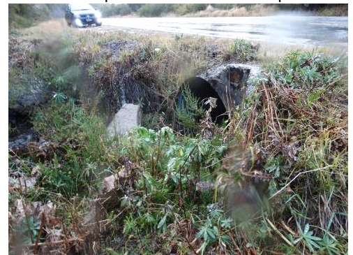
Alcantarilla de D2bis
