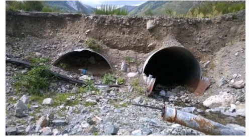
Alcantarillas de D2 (hacia la costa).
