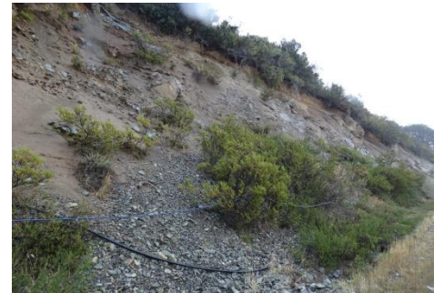
Talud expuesto. Paso de fibra óptica
