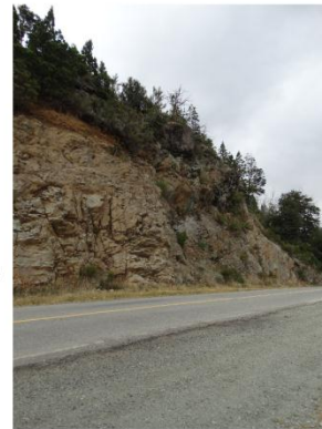
Zona de Taludes
