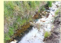
Fig. 6: Residuos arrojados en canales de desagües.
