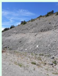
Fig. 1: Talud en Circunvalación
