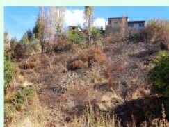
Fig. 3: Talud en zona urbana
