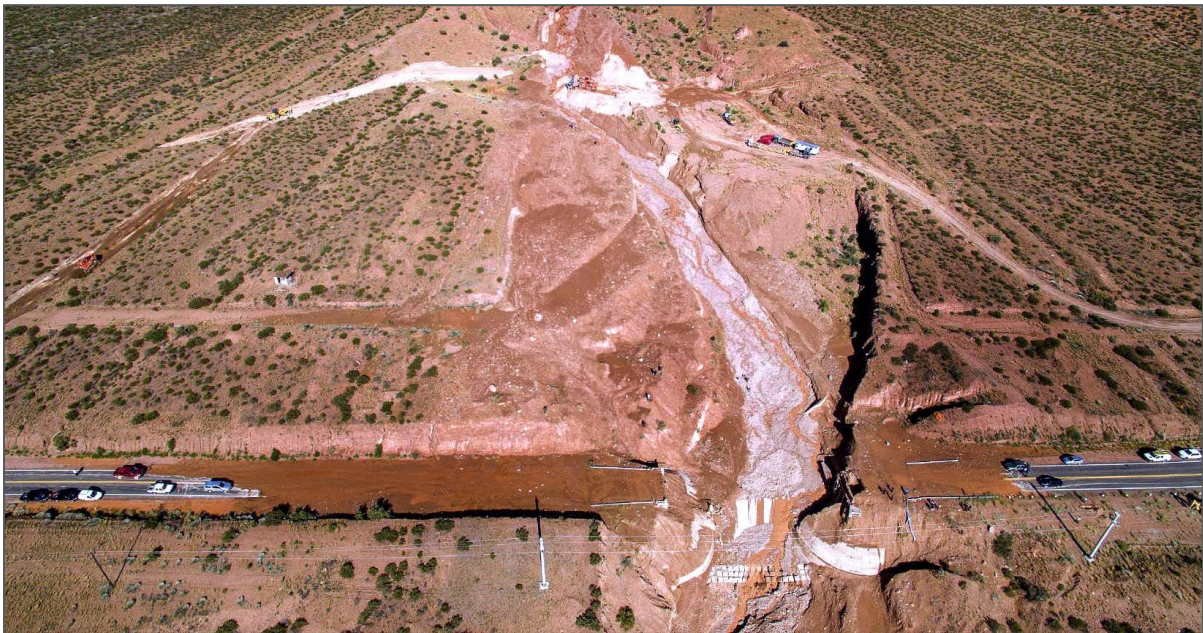
Rotura de puente de la Ruta Nacional 7 (Mendoza) a causa de un flujo de detritos ocurrido a las 18:00 del 01/02/2016 en la microcuenca Soltera. Fotografía extraída de diario Los Andes (2019)
