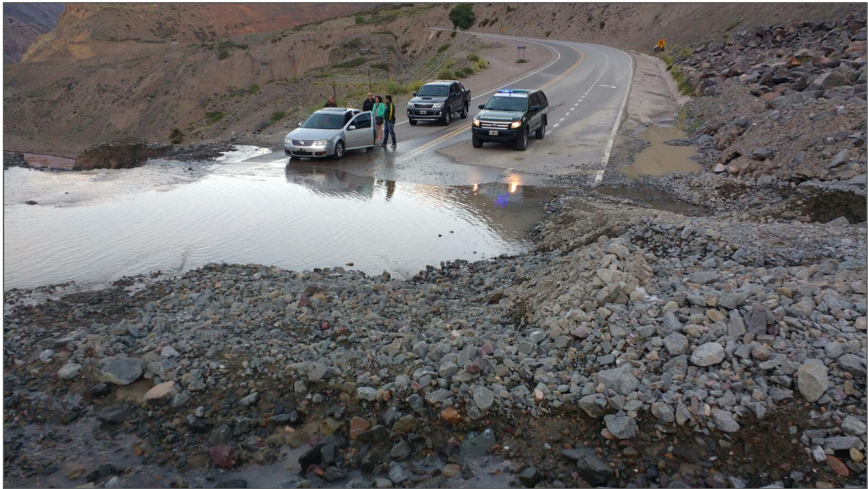
Obstrucción de la Ruta Nacional 7 (Mendoza) debido al flujo de detritos ocurrido por fusión el 28 de diciembre del 2015 en la microcuenca Arroyo Taure
