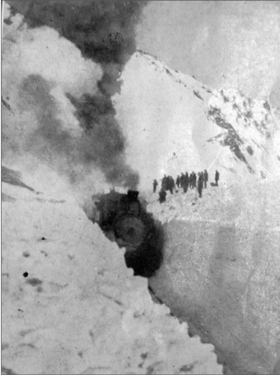
Gran nevada del siglo XX en el valle del Río Mendoza obstruye las vías del ferrocarril Trasandino. Fotografía obtenida de la página web Mendoza Antigua (2019)
