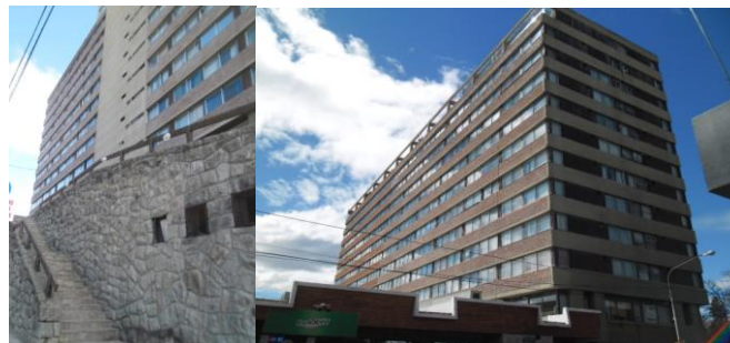
Imagen n° 3: edificio BC. A la Izquierda: vista desde calle Pagano. A la Derecha: vista desde Av. San Martín.
