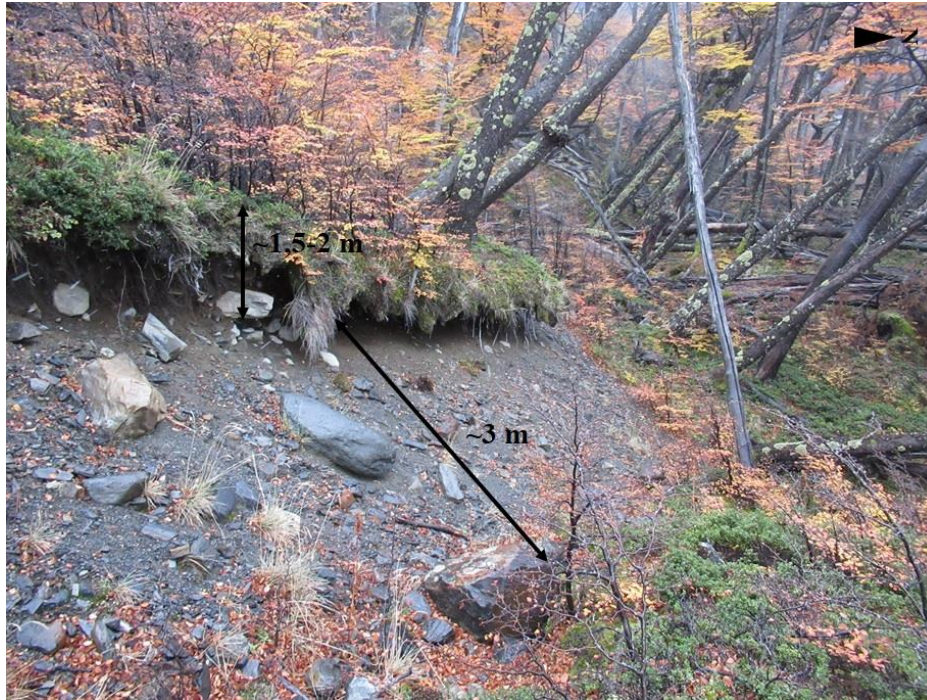
Figura 51-VII: Medidas aproximadas de una grieta de tensión sobre la ladera occidental (Foto gentileza de Esteban Lannutti, abril 2018).
