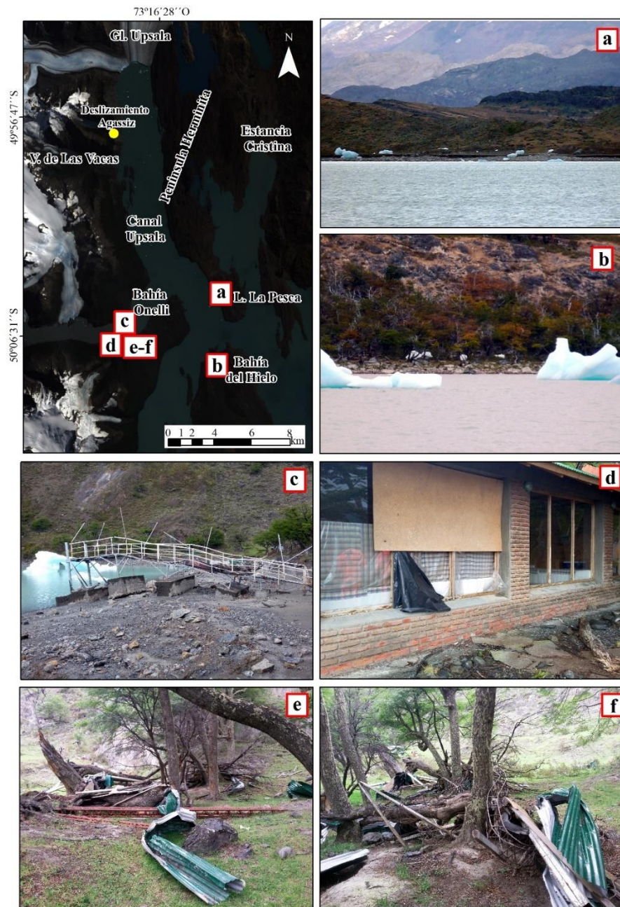
Figura 42-VII: (a) Témpanos depositados sobre península Herminita, laguna La Pesca y (b) sobre bahía del Hielo (Fotos gentileza del Gpque. Mariano Moroni de febrero del 2013, dos días posteriores al evento), (c) muelle destruido, (d) daños sobre el restaurant, (e-f) materiales de construcción del refugio de bahía Onelli (Fotos: Silvana Moragues, noviembre de 2017).
