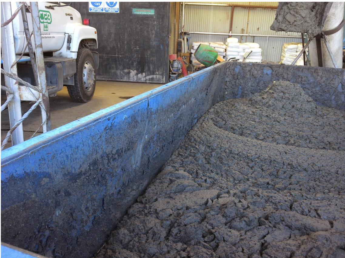
Figura 2.6 – Volquete con lodos deshidratados en la planta depuradora
