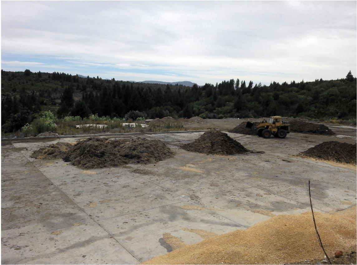
Figura 2.8 – Plateas de concreto sobre las que se realiza el compostaje, al fondo se observan los tanques de almacenamiento de lixiviados
