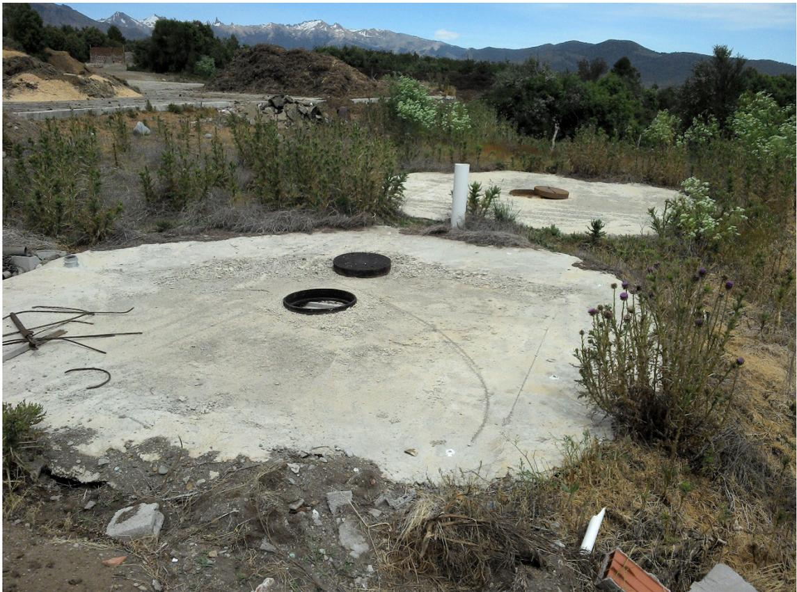
Figura 2.9 – Tanque de almacenamiento de lixiviados
