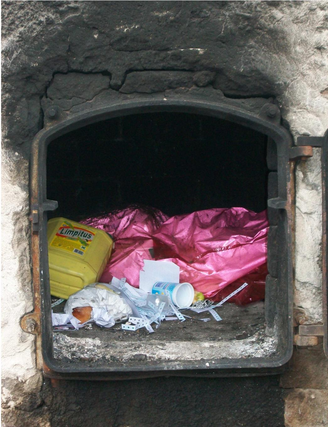
*Foto 2: Residuos en horno incinerador, donde se observa la quema conjunta de los residuos patológicos y residuos comunes.*
