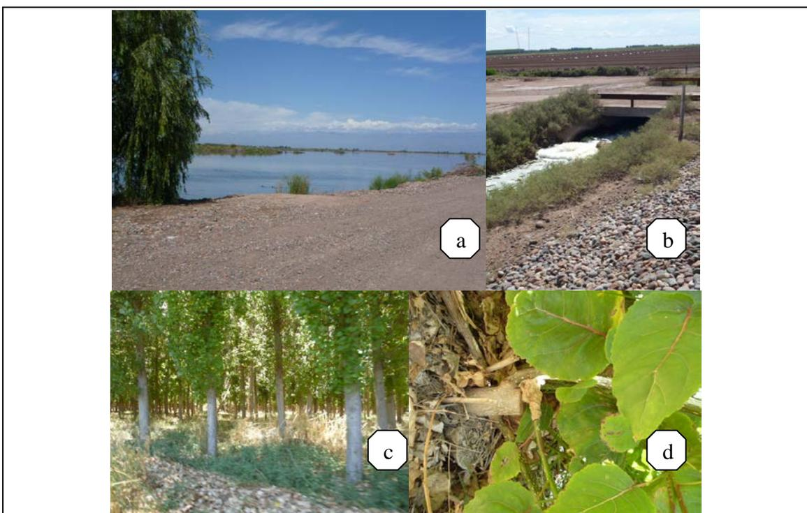
Foto N° 1.II. Sistema de tratamiento Paramillos y reuso para riego de álamos. Lagunas de tratamiento (a), sistemas de distribución de efluentes (b) y riego de salicáceas con agua residual tratada (c y d). (Fotos Ing. M. Riat, UNRN).
