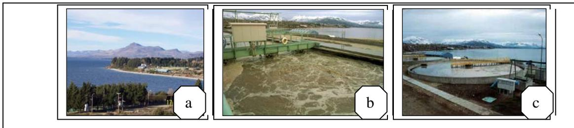
Foto 5.II. Planta de tratamiento de la ciudad de San Carlos de Bariloche. Vista ubicación planta (a) (Foto, DPA Lic. Alemanni). Vista reactor (b) [rionegro.com.ar](http://rionegro.com.ar) 19-03-2012. Vista sedimentador (c) [diarioandino.com.ar](http://diarioandino.com.ar). 19-03-2012
