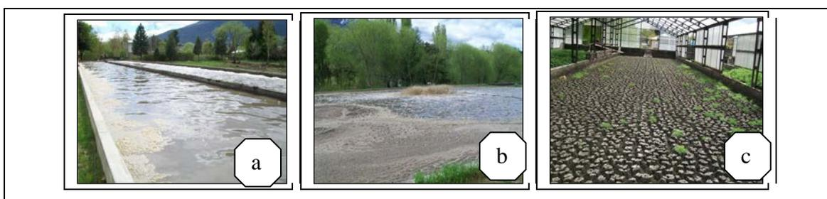
Foto 6.II. Planta de tratamiento de la ciudad de El Bolsón: reactor (a), digester de lodos (b) y playa de secado (c). (Fotos Lic. Alemanni, DPA).
