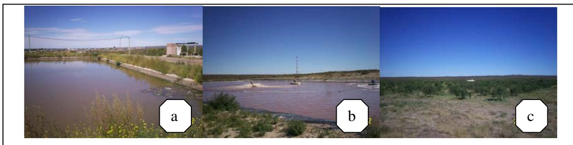
Foto 3.II. Sistema de tratamiento de las aguas residuales por medio de lagunas (a y b) y reuso de aguas residuales tratadas en plantaciones de olivos (c) en el balneario Las Grutas, provincia de Río Negro. (Fotos Ing. Eliana Sañudo, DPA).
