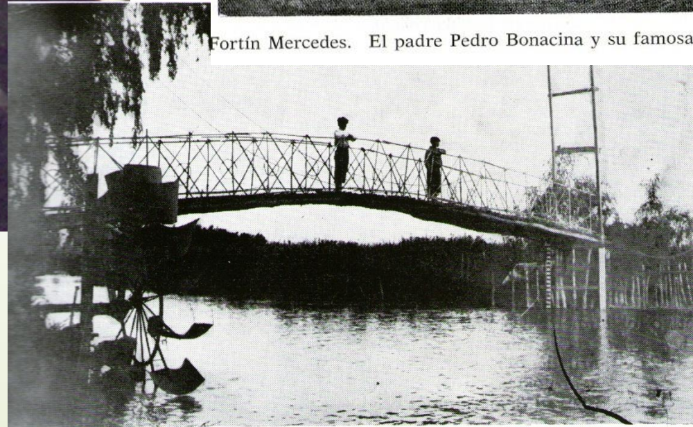
Fortín Mercedes. Puente colgante sobre el río Colorado, obra del P. Pedro Bonacina. Año
