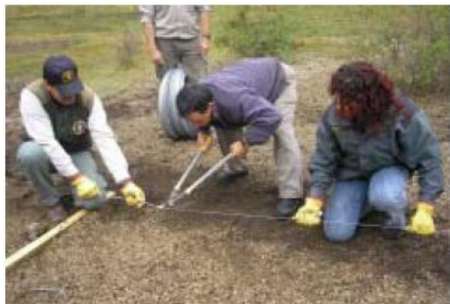
Personal del Parque instalando el alambrado Foto: S. Seijas
