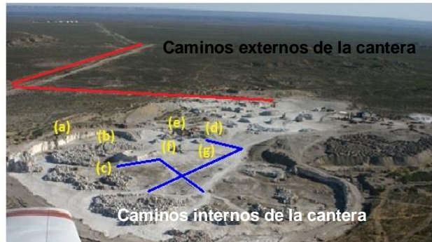
Figura 2 – Principales Operaciones de la actividad minera: a) Manejo de suelo, b) Perforación y voladura, c) Manejo de materiales y transporte del material sobre caminos no consolidados, d) Molienda Primaria e) Clasificación, f) Despacho sobre caminos consolidados, g) Erosión eólica.
