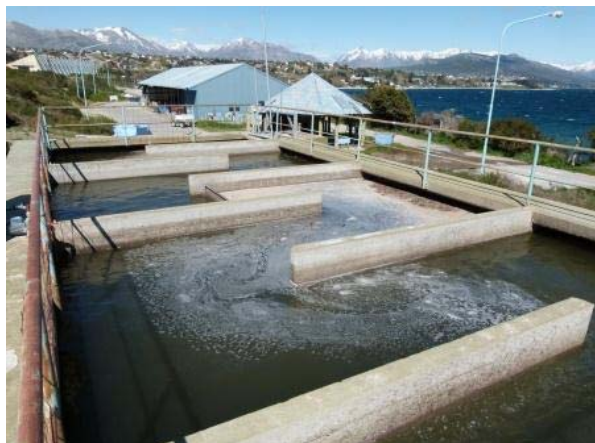
Figura N°19 Cámara de desinfección. Fuente: imagen propia.
